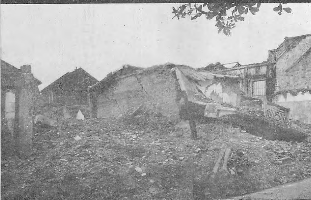
上 すべての屋根瓦がとんだ 下 町全体が破かいされる
