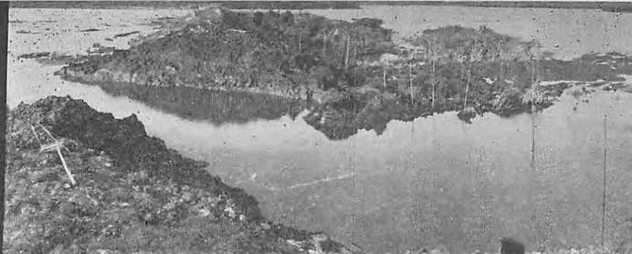
堤防も爆破される (1966・8・6)
